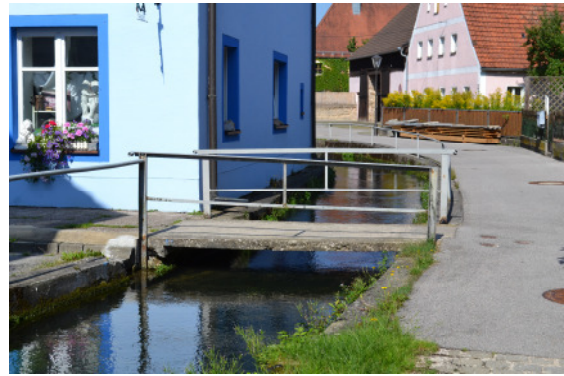
Abb.: Brücke in der Brauhausgasse (Quelle: em.Architekten)
