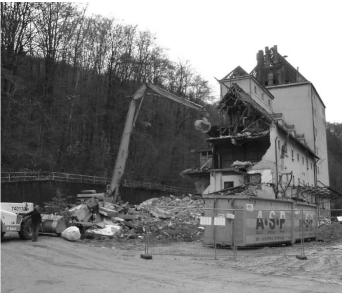
Die Abbrucharbeiten an der Baywa im Nov./Dez. 2013
