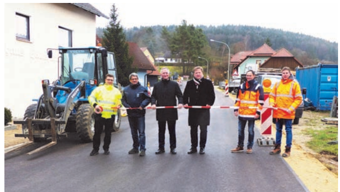
Die Verkehrsfreigabe der sanierten Staatsstr. 2240 von Utzenhofen bis zur Landkreisgrenze NM erfolgte nach 8 Wochen Bauzeit. Von links: Stefan Noll, Straßenbauamt; Thomas Magerl, Fa Schulz; MdL Dr. Harald Schwartz; Bürgermeister Stefan Braun; Stefan Weiß, Straßenbauamt
