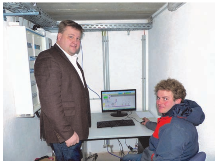
Bürgermeister Stefan Braun (links) und Bernhard Hüttner begutachten im Heizwerk am Klosterberg das Ergebnis der Leitungsüberwachung im Zentralrechner
