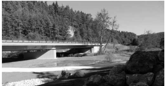
Blick auf die neue Lauterachbrücke mit verlegtem Radweg im Vordergrund sowie aus Naturschutzgründen geschaffene Seigen und Strukturen im Umfeld der Lauterachbrücke
