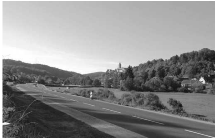
Blick über die verlegte Trasse der St 2235 zur Klosterburg
