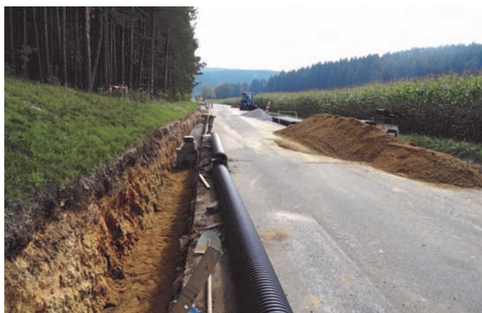
Die Straßenentwässerungseinrichtung wird ebenfalls erneuert
