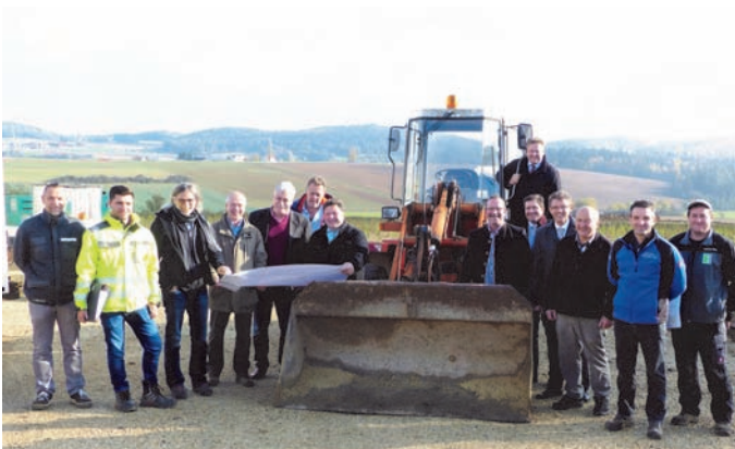
Zum „Spatenstich“ für das Gewerbegebiet Kastl II fanden sich zahlreiche Vertreter der Marktgemeinde Kastl mit Bürgermeister Stefan Braun (am Lader Bildmitte) sowie Vertreter der Planungsbüros, Baufirmen und des Finanzierungsinstituts ein. KFB Bauprojektleiter Freddy Leberkern (4. v. l.) hatte mit der Gemeinde dazu eingeladen
