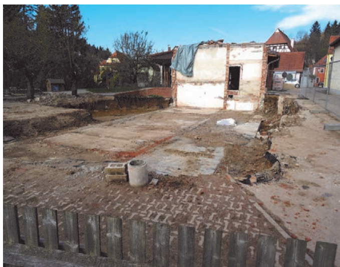
Der Altbau des Kindergartens wurde abgerissen, der Neubau aus den 80er Jahren bleibt stehen und wird mit saniert
