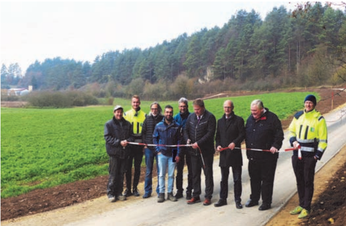
Die beiden Bürgermeister Stefan Braun und Ludwig Lang (Mitte) durchschneiden das Absperrband symbolisch und nehmen die sanierte GV-Straße zwischen dem Hallerbrunnen (Hintergrund) und Pattershofen (Kastl) in Betrieb, die in zweimonatiger Bauzeit den modernen Verkehrsverhältnissen angepasst wurde und Teil des vielbefahrenen Fünf-Flüsse-Radwegs ist
