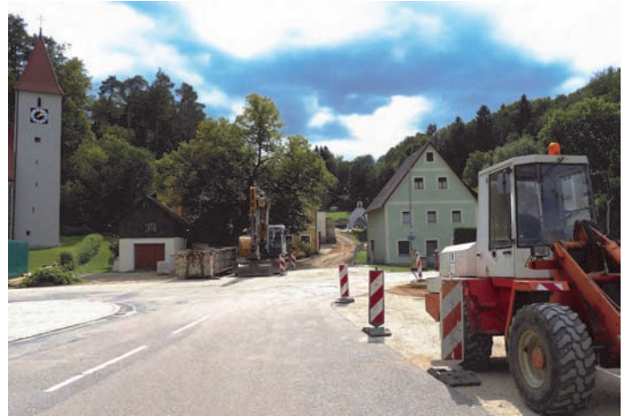
Die Dorferneuerung in Pfaffenhofen hat mit den Arbeiten oberhalb des Friedhofs, wo ein Regenrückhaltebecken und ein Wassereinlauf entstehen, begonnen
