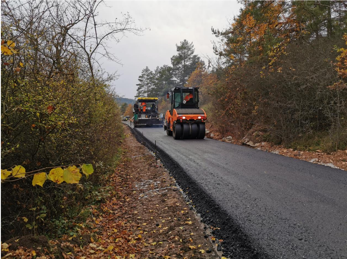
Asphaltierungsarbeiten für die Tragschicht am Dienstag, den 29.10.2019
